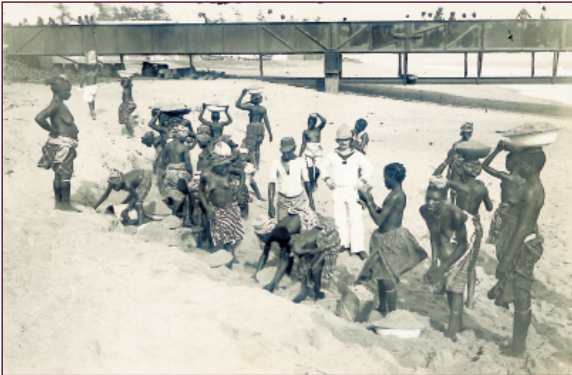
Abbildung 24: angeschwemmter Sand wird abgetragen – für den Straßenbau
