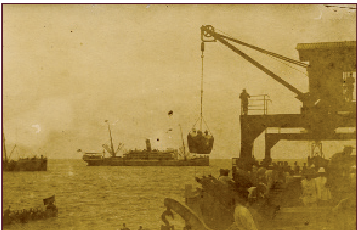
Abbildung 17: Lome - Anlandung von Passagieren mittels Dampfkran und Holzgondel.
