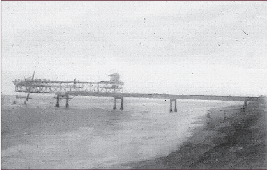
Abbildung 9: Die Landungsbrücke im Bau (1903), mit dem später wieder abgetragenen Konstruktions-Überbau.
