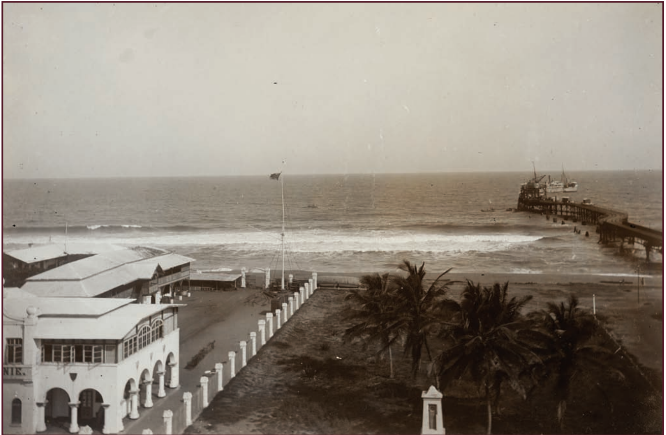
Abbildung 37 : Das Woermannhaus und die „krumme“ Brücke ca. 1913
