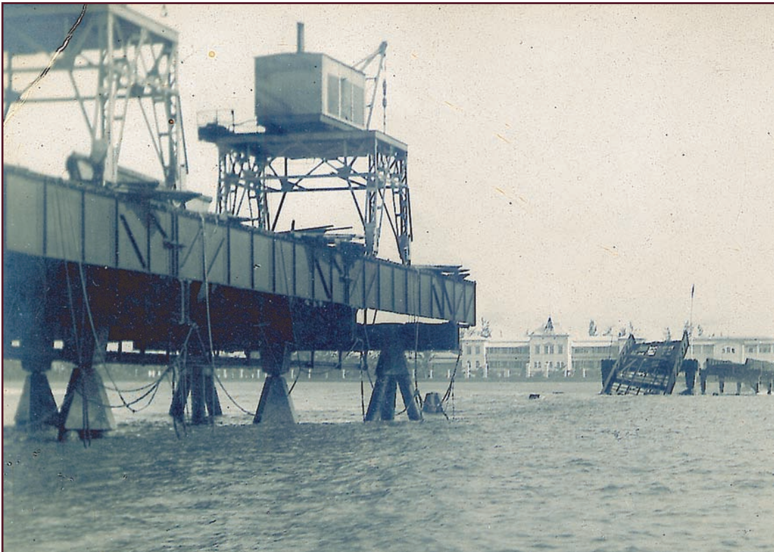
Abbildung 28: Die zerstörte Landungsbrücke - Aufnahme von der Seeseite
