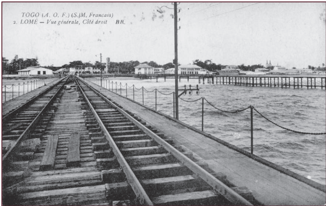
Abbildung 41: Die von der französischen Mandatsregierung erbaute neue Landungsbrücke mit acht Dampfkränen – etwa 100m länger als die 1928 zerstörte alte deutsche Brücke.
