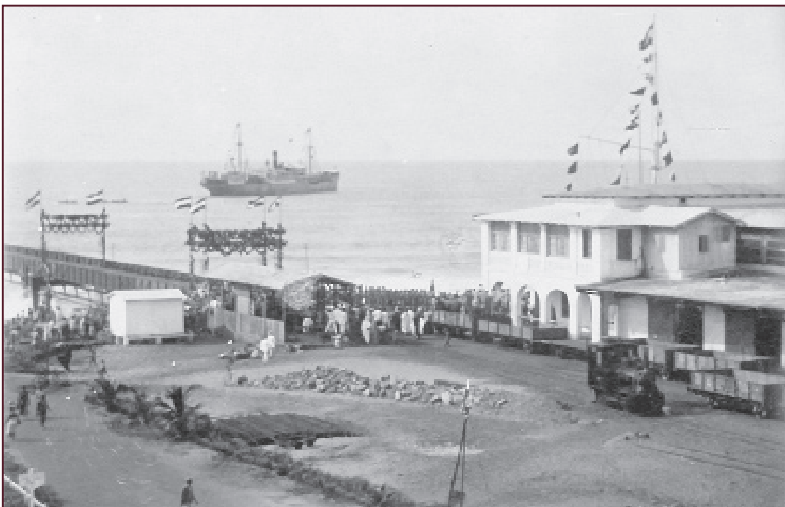
Abbildung 12: Eröffnungsfeier vor dem Zollgebäude am 27.1.1904, noch mit Bauschutt und Festzelt am Brückenanfang.
