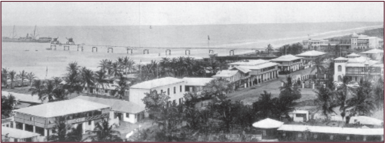
Abbildung 15: Lome - Panorama der westlichen Küste mit Landungsbrücke und zwei Kränen.
