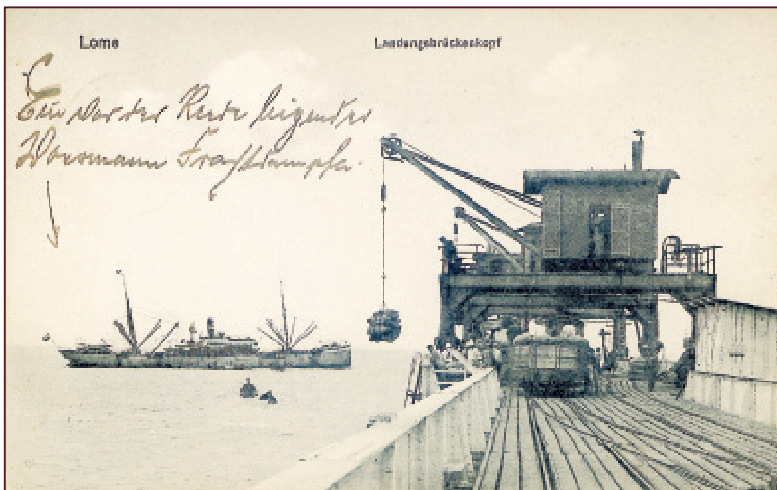
Abbildung 14: Dampfkräne (bis zu 6t Ladekapazität) am Brückenkopf
