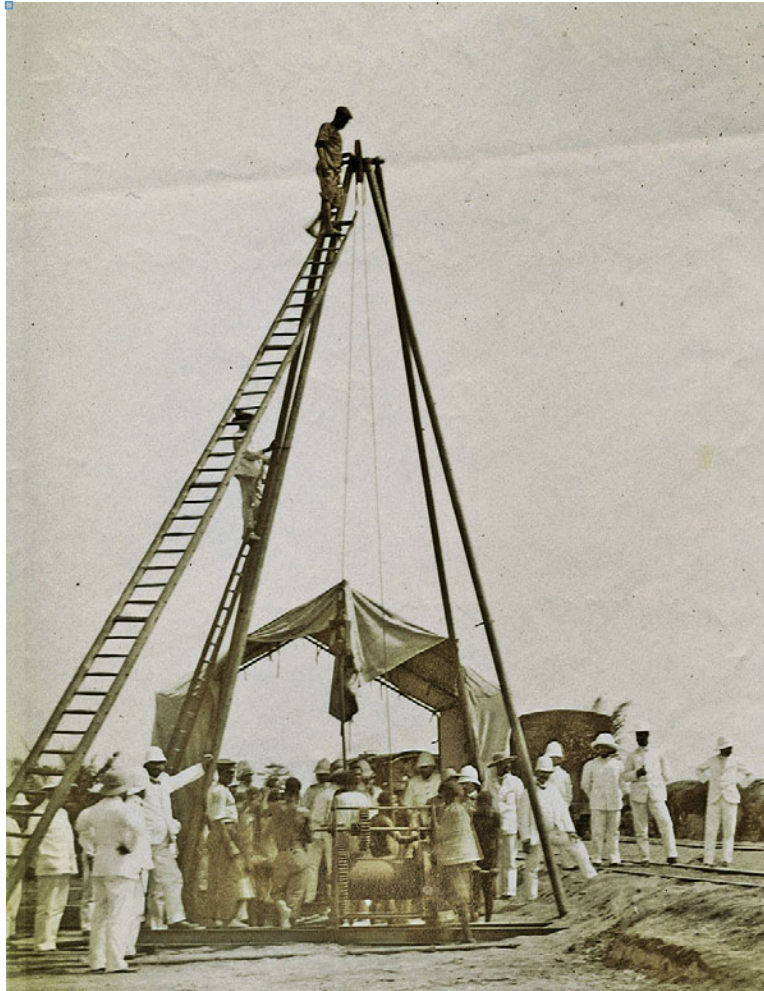
Abb. 4: Brunnenbohrung bei Akeve
