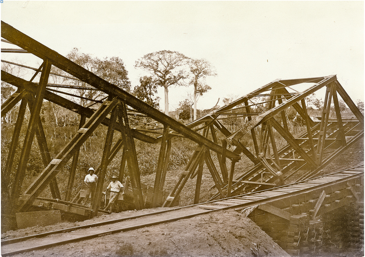
Abb. 24: Vormarsch der Briten im Weltkrieg – eine Notbrücke neben der gesprengten Chra-Brücke auf dem Weg nach Kamina
