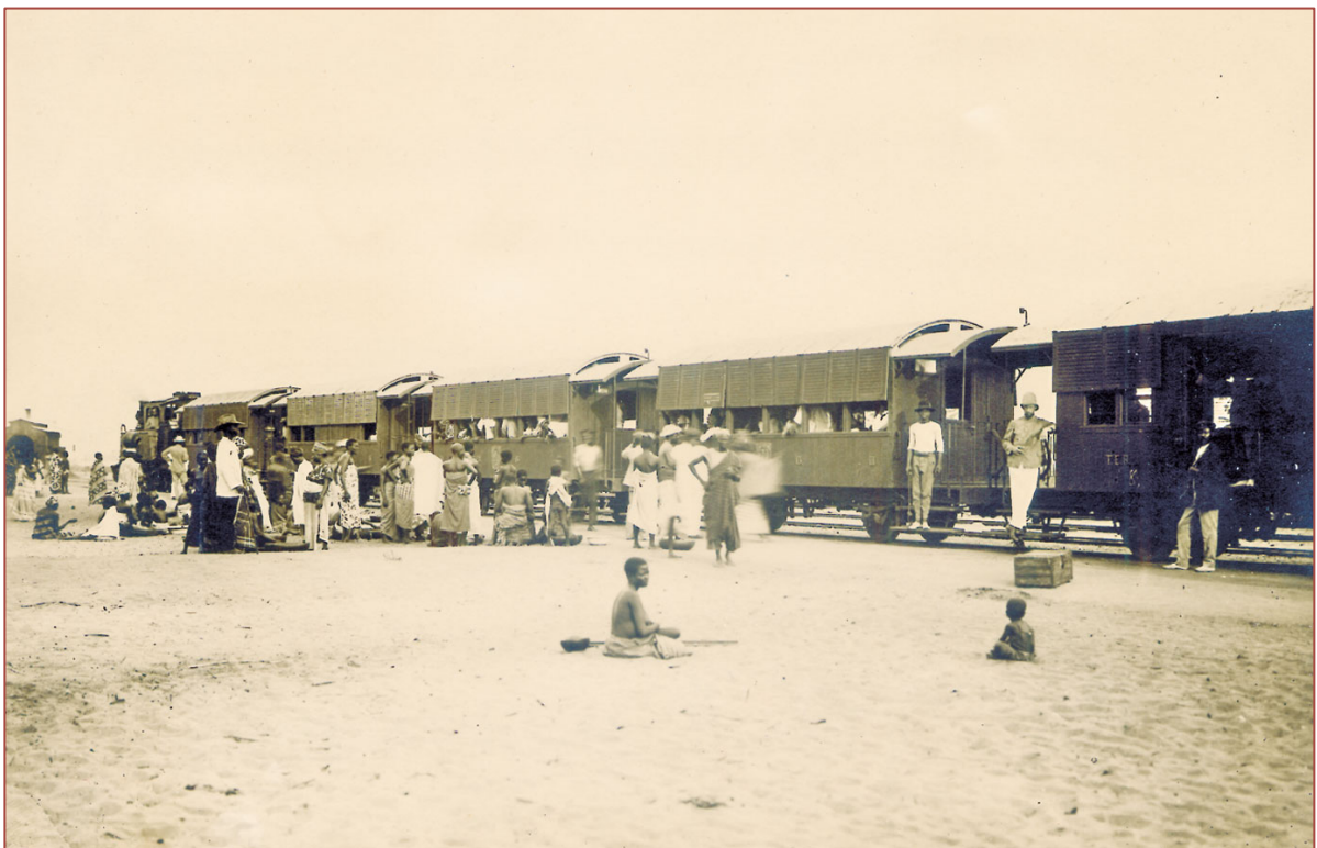
Abb.17: Endstation Anecho (km 44) – Passagiere und fliegende Händler vor einem Personenzug.
