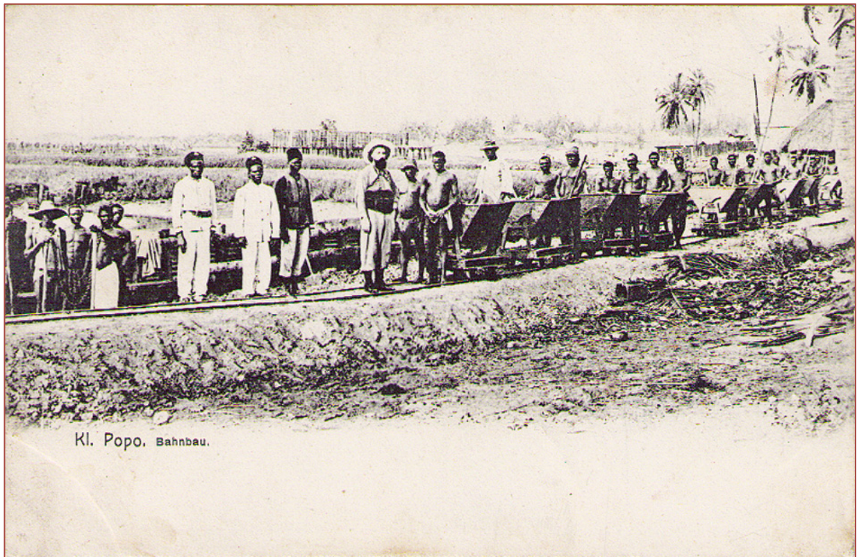
Abb.5: Bau der Kleinbahn mit 75cm Spurweite in Klein-Popo vor 1904
