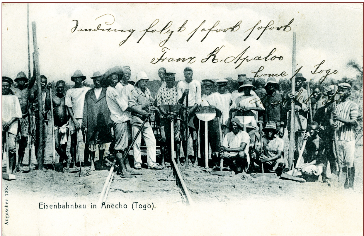
Abb. 6: 1904, Umbau der Küstenbahn auf 1m Spurweite 1904/05 bei Anecho (der Name „Klein-Popo“ war ab 1905 nicht mehr gebräuchlich).
