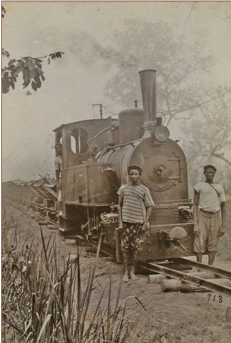
Abb. 2: seltenes Foto vom Bau der primitiven Küstenbahn vor 1904, mit einer Spurbreite von 75cm. Als Schwellen dienten offenbar Baumstämme, zwischen welche Schotter aus den Loren hinter der Lokomotive geschüttet und vom nachfolgenden Arbeitstrupp festgestampft wurde.
